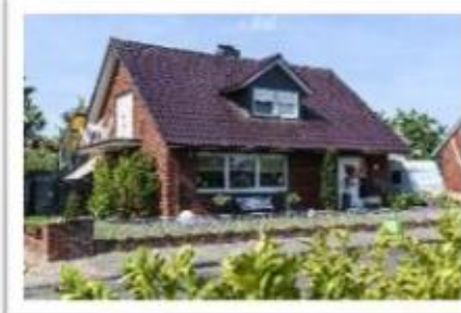
140 m 2 Mäßig gedämmt Normale Heizkörper 14 kW
